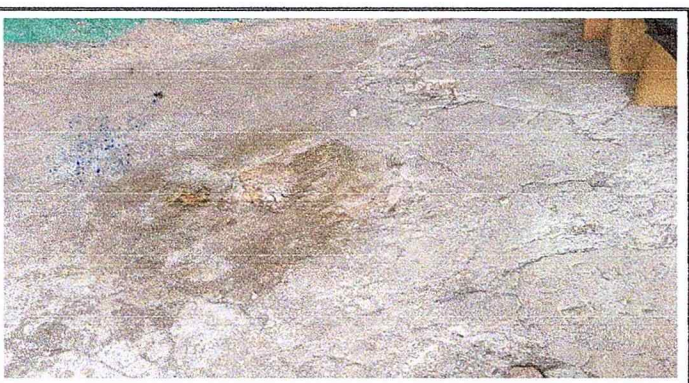
Foto 3: SUSTITUCION DE PISO DE CEMENTO A PISO CERAMICA
